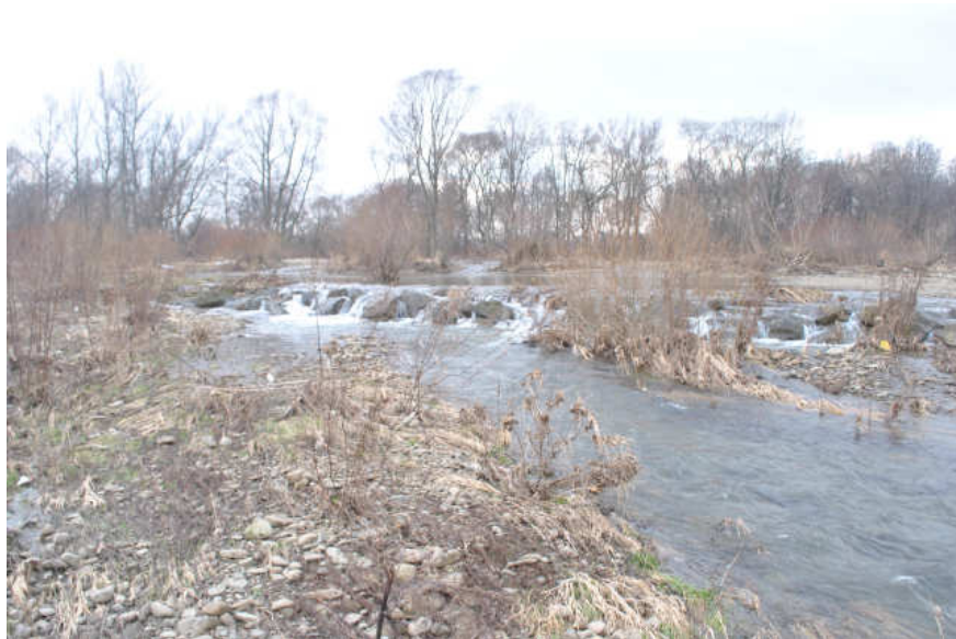
Fot. 15, 16: Elementy progu w km 7+400 umożliwiające migracje ryb w górę rzeki
