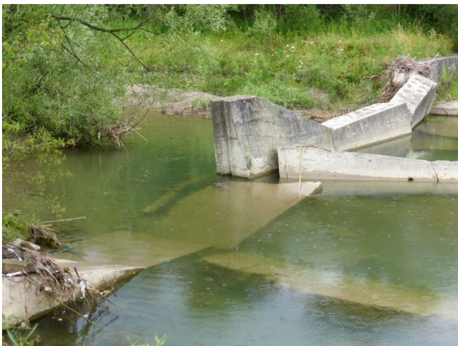
Fot. 21, 22. Słomka 7. Próg zniszczony podczas powodzi w 2010 r. Nie stanowi bariery migracyjnej
