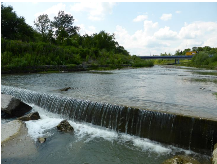
Fot. 15, 16. Słomka 1. Pojedynczy próg betonowy + kamień łamany. Powyżej 2 małe progi o wys. 0,1 m. Bariera migracyjna
