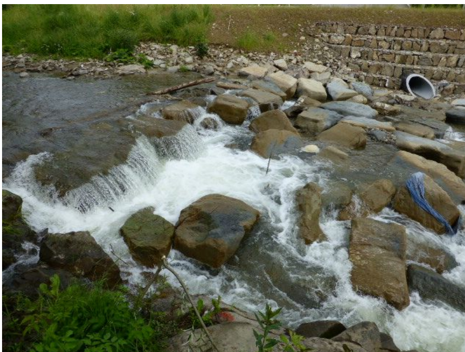
Fot. 5, 6. Próg Ochotnica 4. Rampa z kamienia łamanego, częściowo zniszczona. Bariera migracyjna
