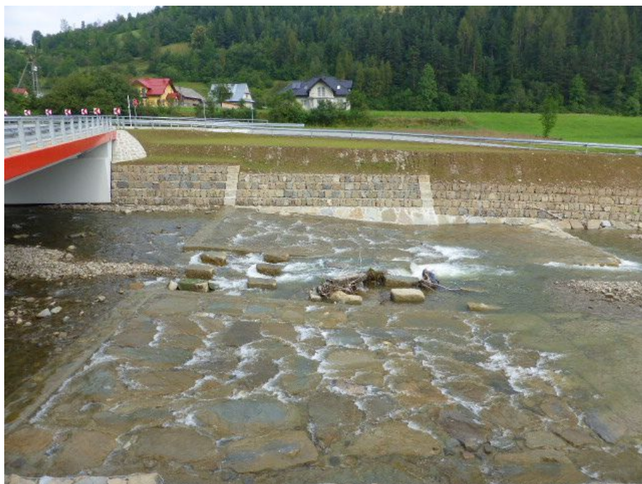
Fot. 3, 4. Próg Ochotnica 3. Rampa o nachyleniu 12°, zaopatrzona w przepławkę o szerokości 6 m. Swobodna migracja ryb
