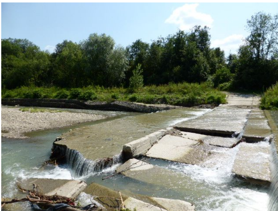
Fot. 17, 18. Słomka 2. Zniszczony próg. Bariera migracyjna
